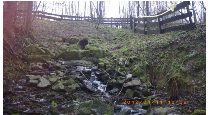
Einleitung ins HRB
