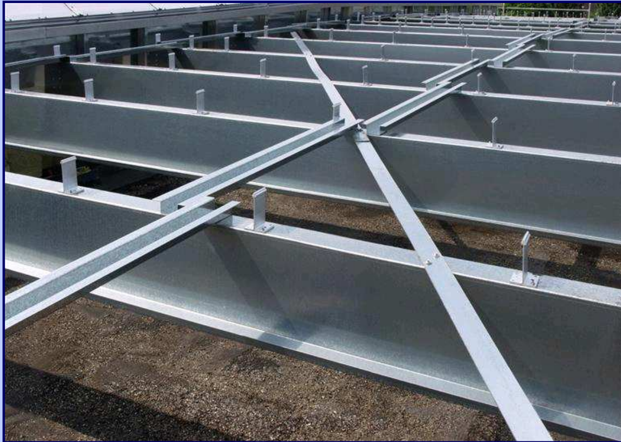
Unterkonstruktion des neuen Aluminiumdaches
