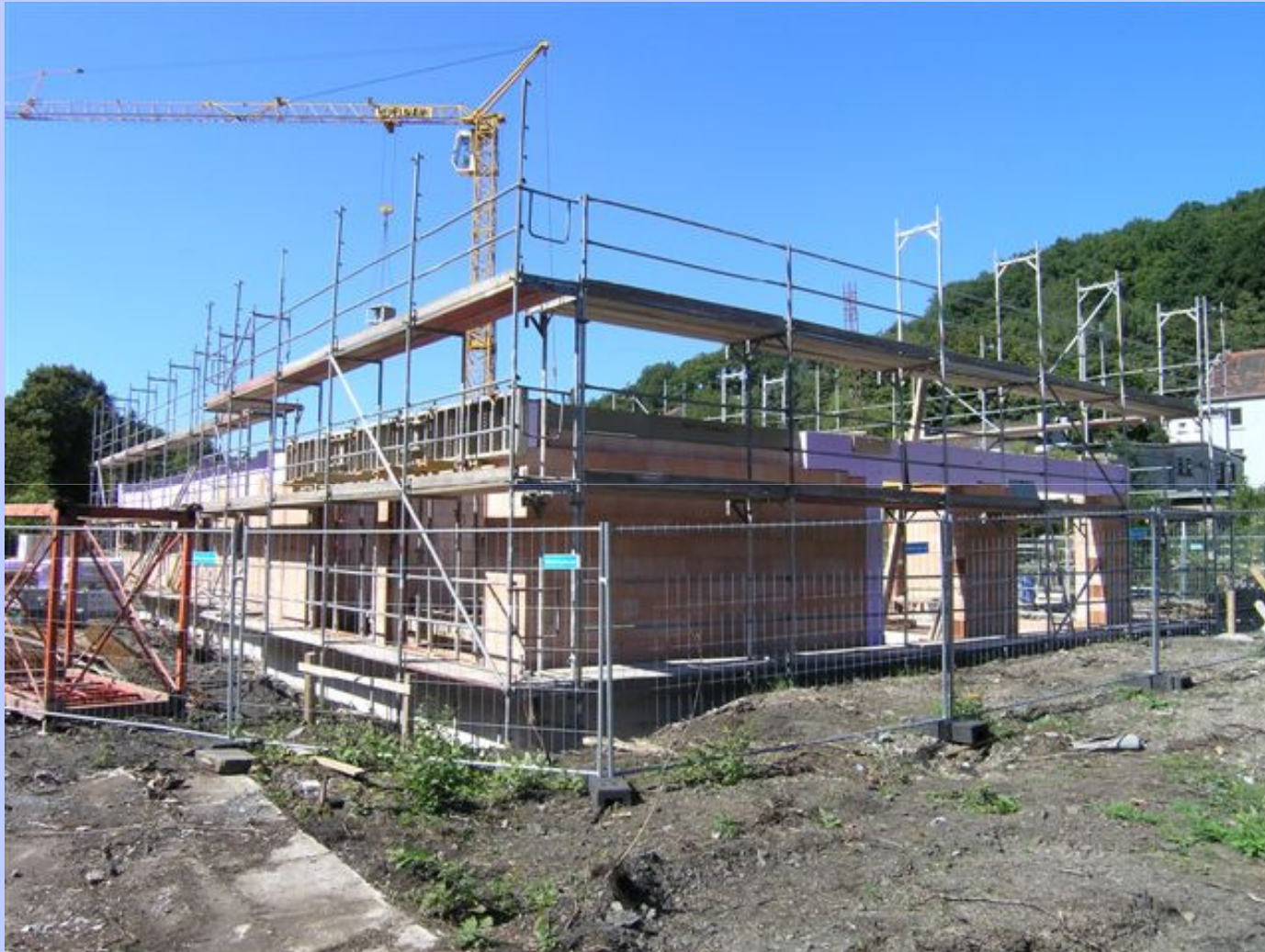
Neubau FW-Gerätehaus in Brügge (Stand 09/2013)
