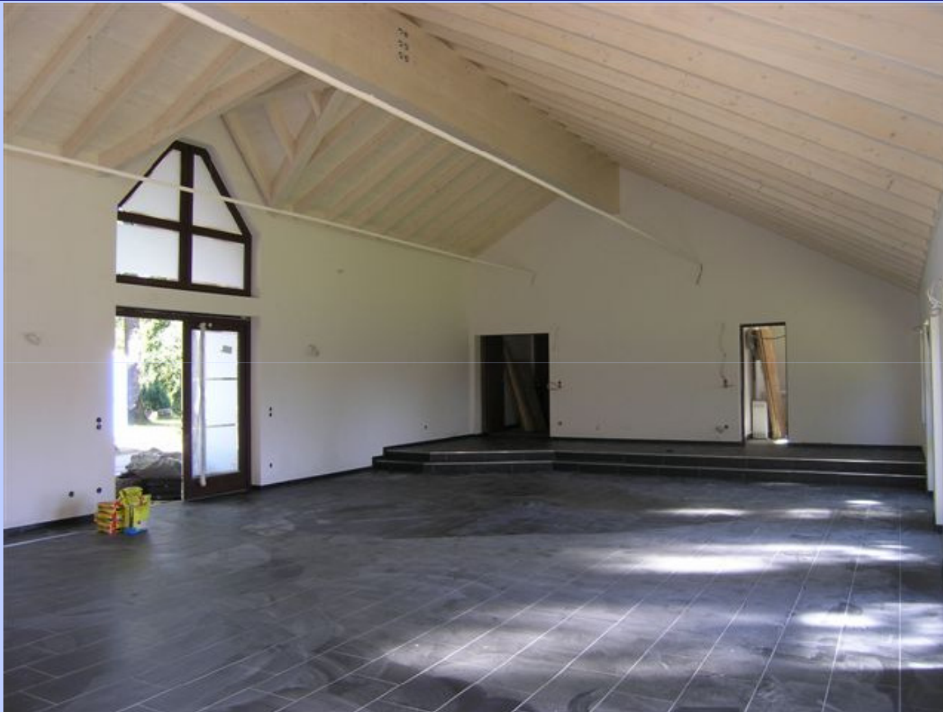
Anbau Trauerhalle Loh (Stand 09/2013)
