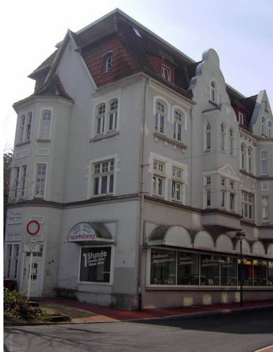
Dachflächenfenster ordnen sich in Größe und Anzahl unter
