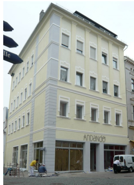
nach dem Umbau
