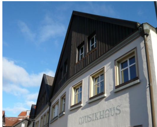
Beispiel einer Holzverkleidung im Giebel, Ringmauerstraße 10
