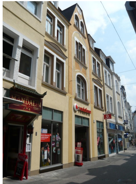
nach dem Umbau
