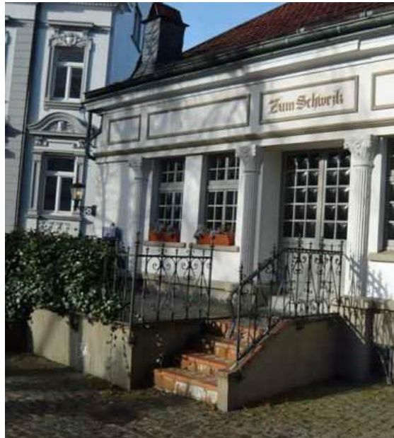
Freitreppen zum Gebäude am Beispiel des Gasthauses Schweijk
