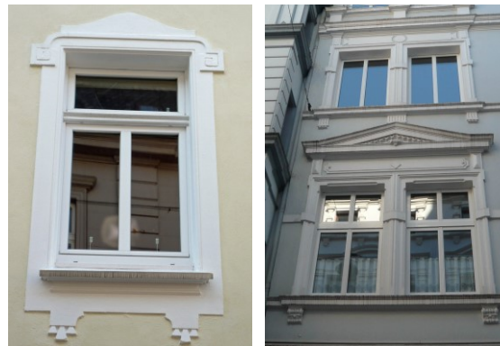
Beispiele von Fenstern mit Fensterfaschen (Stuckumrahmung der Fenster)
