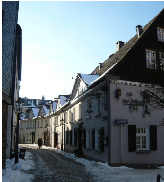
Beispiel Herzogstraße: Gebäude in traufständiger Bauweise mit so genanntem Traufgiebel
