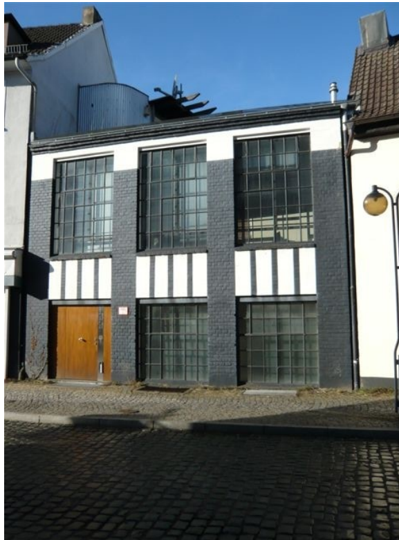
Gelungener Umbau mit Büronutzung, Thünenstraße 11, hier Ansicht von der Corneliusstraße
