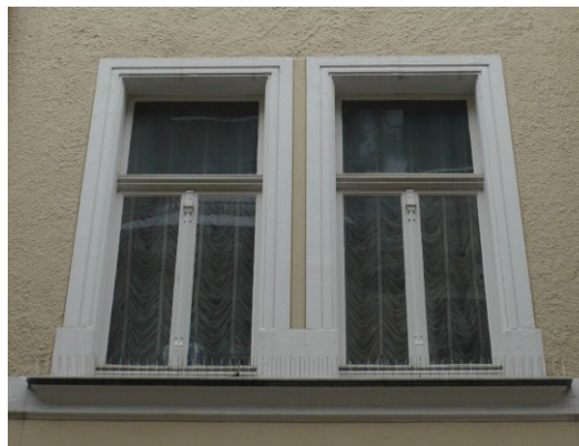
Fensterunterteilung mittels Mittelpfosten und Kämpfer
