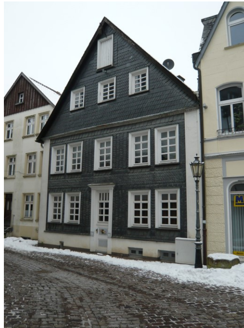
Beispiel eines Schieferhauses, Herzogstraße 21
