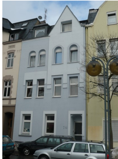
Fassadensanierung Bahnhofstraße 76: Wärmedämmung der Fassade und Ersatz durch gleichwertige Gestaltungselemente
