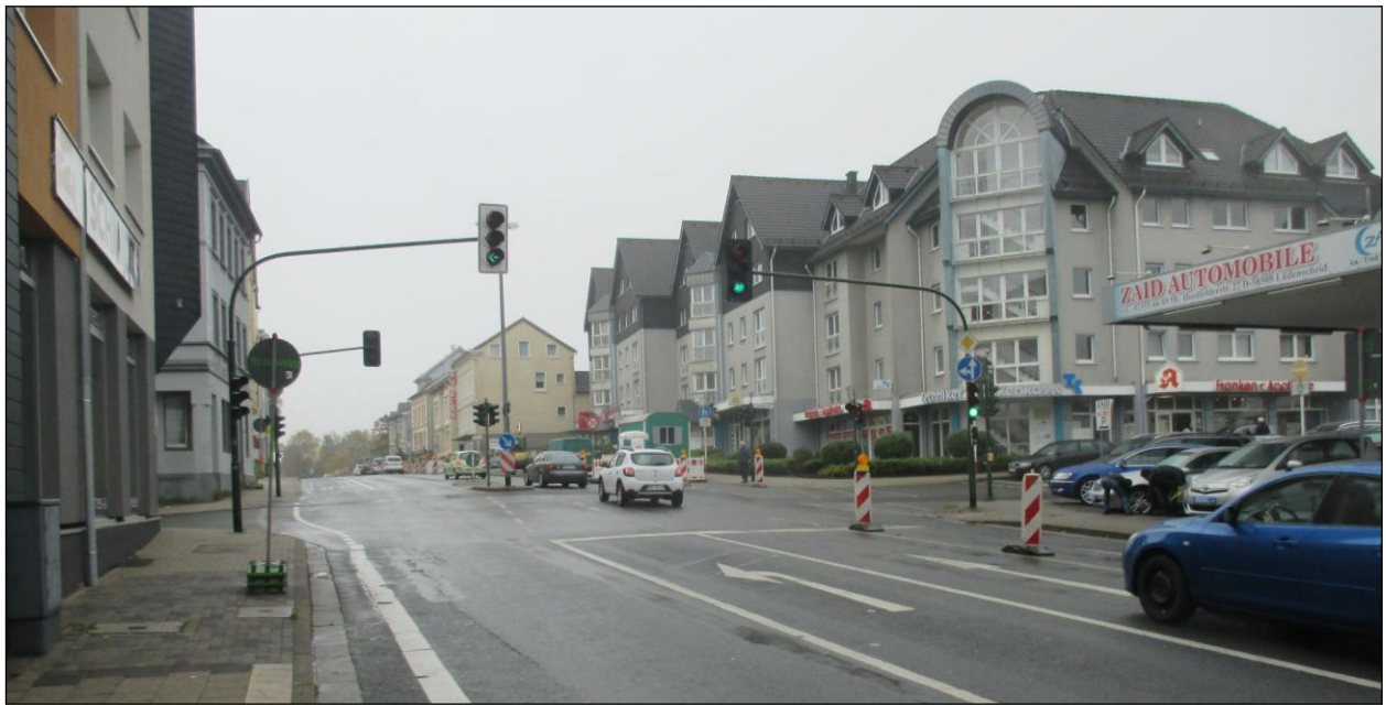
Abbildung 8: Bestandssituation am Knotenpunkt Heedfelder Straße / Ludwigstraße / Frankenstraße
