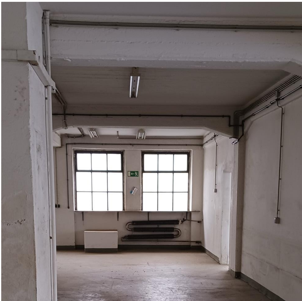
Abbildung 6 Innenraum des Hauptgebäudes, Foto vom 29.10.2025
