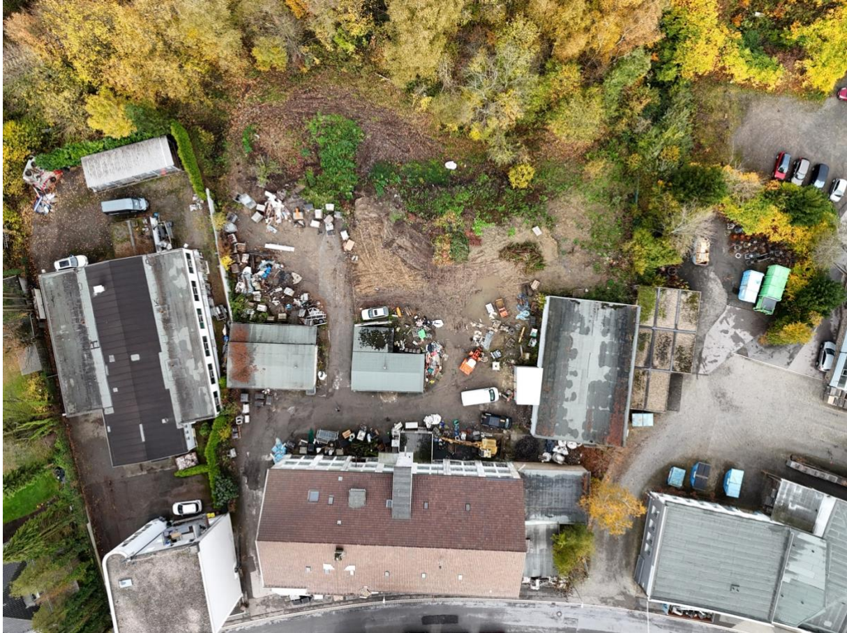
Abbildung 4 Drohnenaufnahme der Vorhabenfläche
