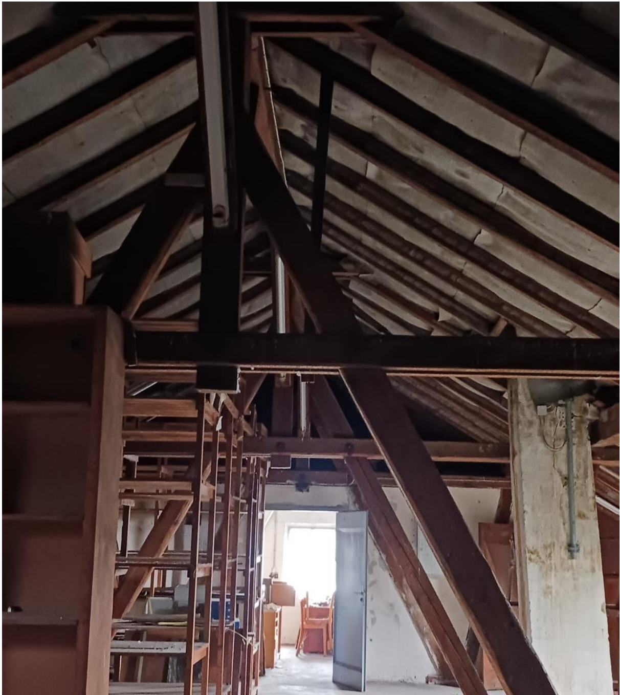
Abbildung 7 Balkenstrukturen auf dem Dachboden, Foto vom 29.10.2025
