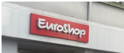
Beispiel einer ausnahmsweise zulässigen Werbeanlage (Flachtransparent mit erhabenem Schriftzug).
