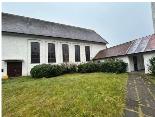
Foto 5: Innenhof Richtung Höher Weg
