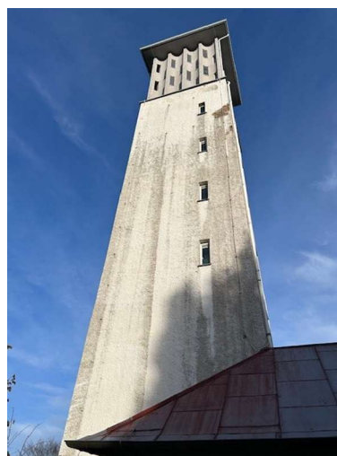
Foto 2: Turm mit Turmfalkeneingang
