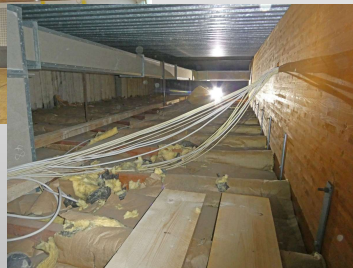
Bauwerksprüfung im Hochbau
