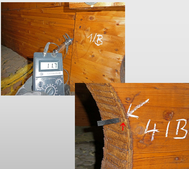
Bauwerksprüfung im Hochbau
