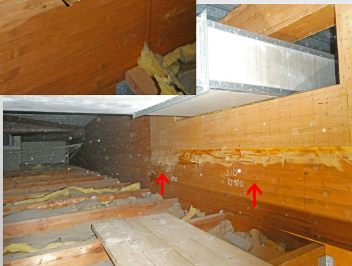
Bauwerksprüfung im Hochbau
