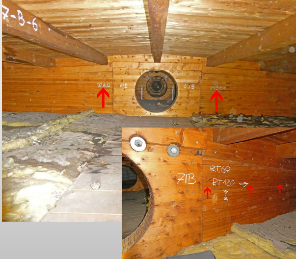
Bauwerksprüfung im Hochbau
