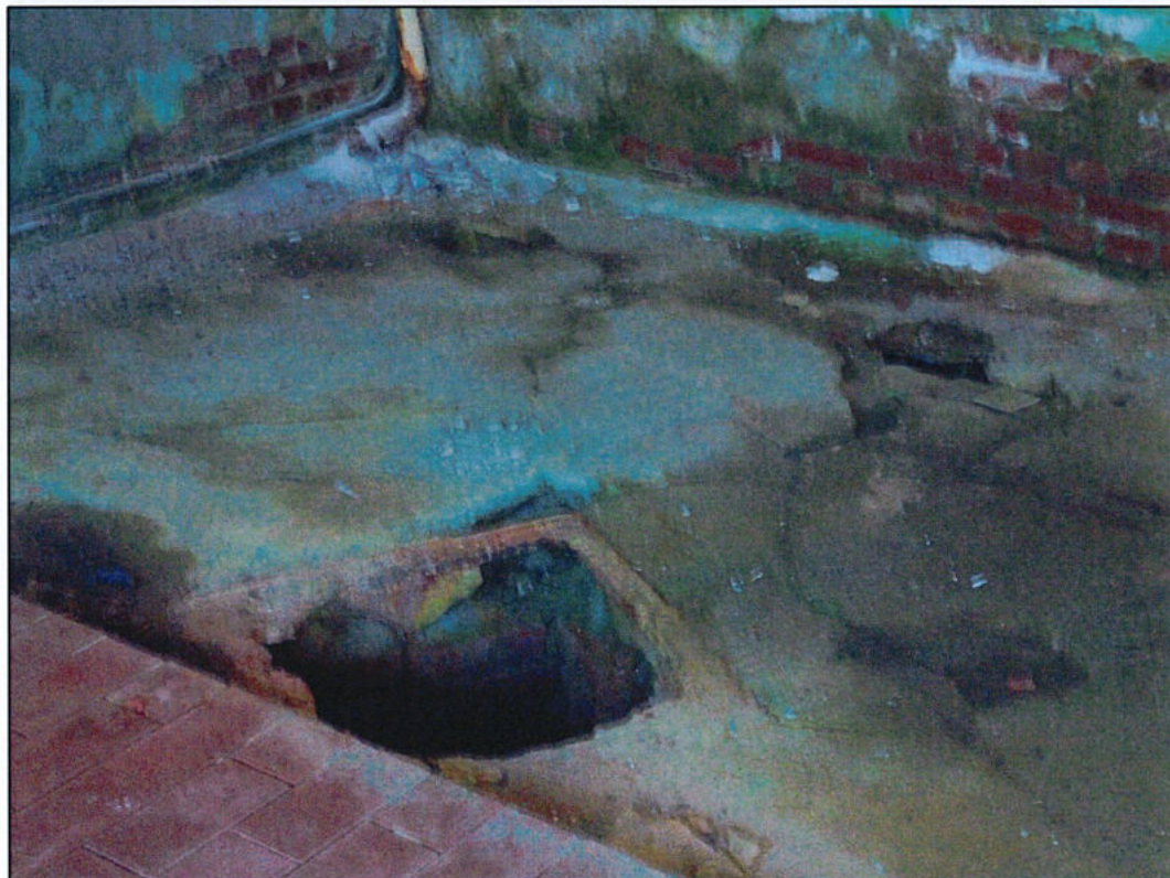
Abb. 14: Detailansicht der Bodenplatte, Nickelbad 2
