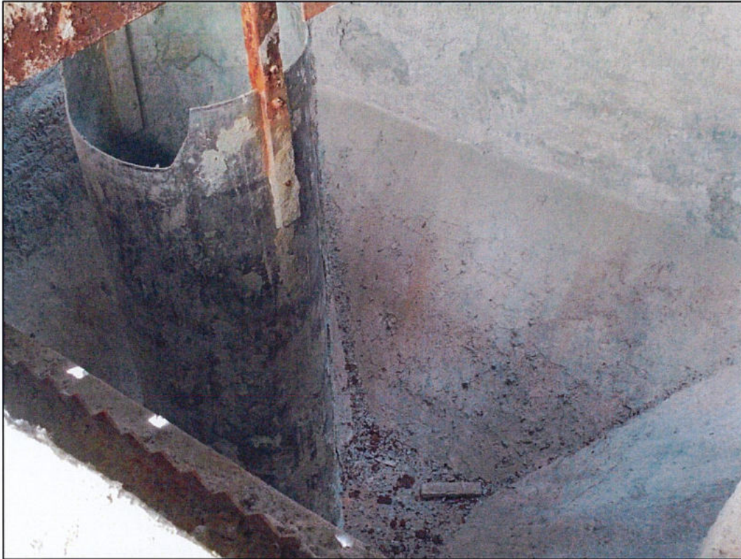
Abb. 9: Detailansicht der Kläranlage
