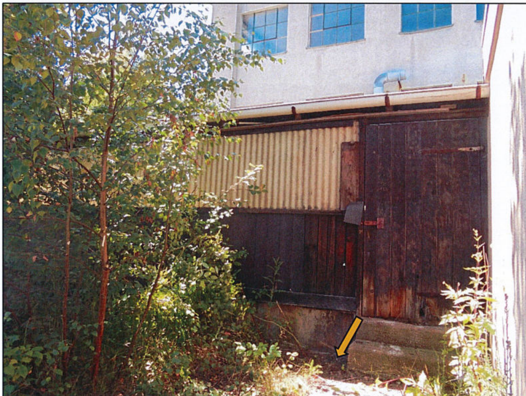
Abb. 6: Gebäude Kläranlage, Ansatzpunkt der RKS 16
