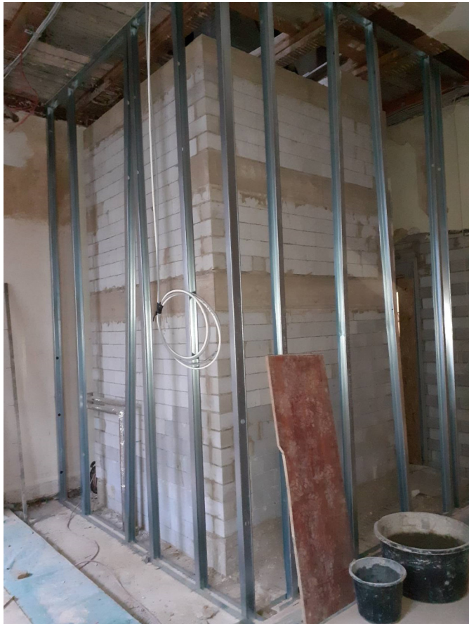
Aufzugsschacht mit Vorsatzschale
