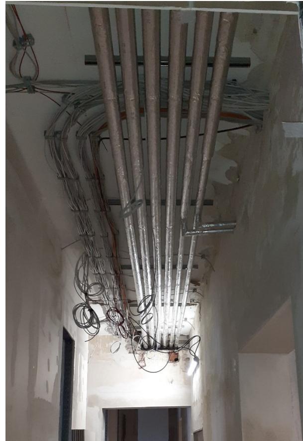
Installationen für Heizung, Sanitär und Elektro sind vorbereitet
