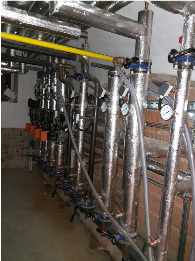
Heizungsverteilung inkl. Pumpen sind erneuert
