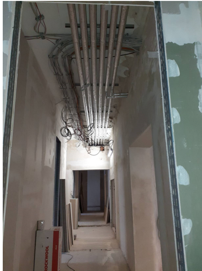
Trockenbauwände und Installationen
