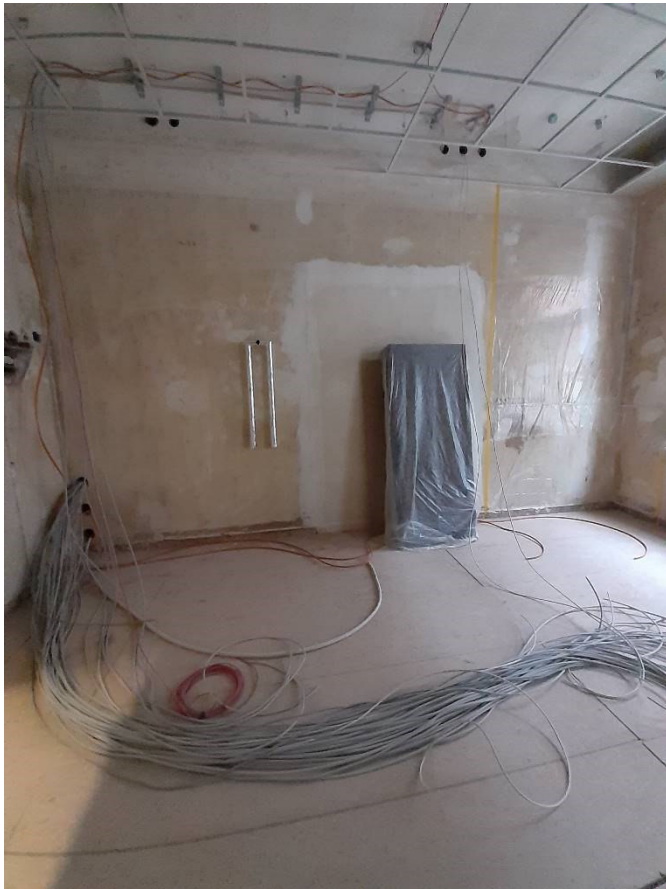
neue Elektro-Unterverteilung Kabelverlegung Wasseranschluss Kaffeeautomat
