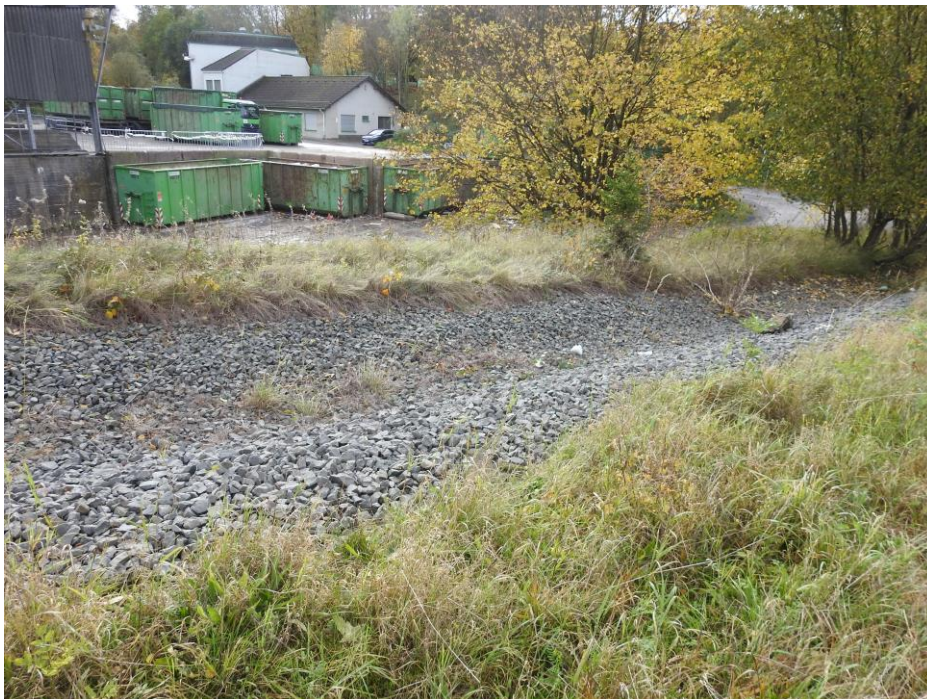
Abb. 6 Schottergraben westlich entlang der Umladestation auf der Deponie Kleinleifringhausen
