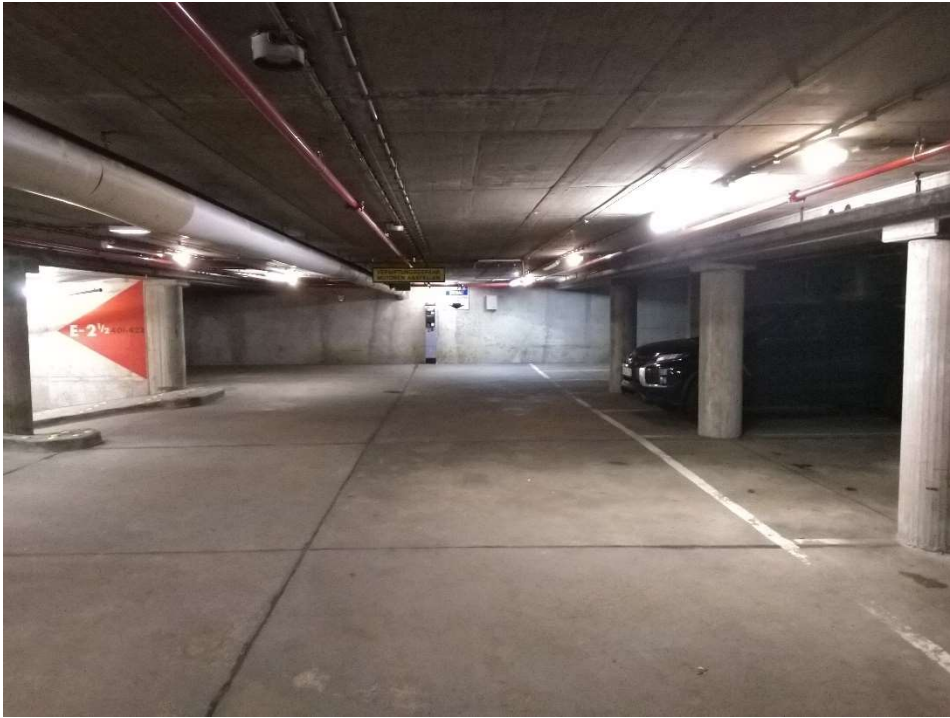
Abb. 16: Tiefgarage unter dem Kulturhaus Lüdenscheid
