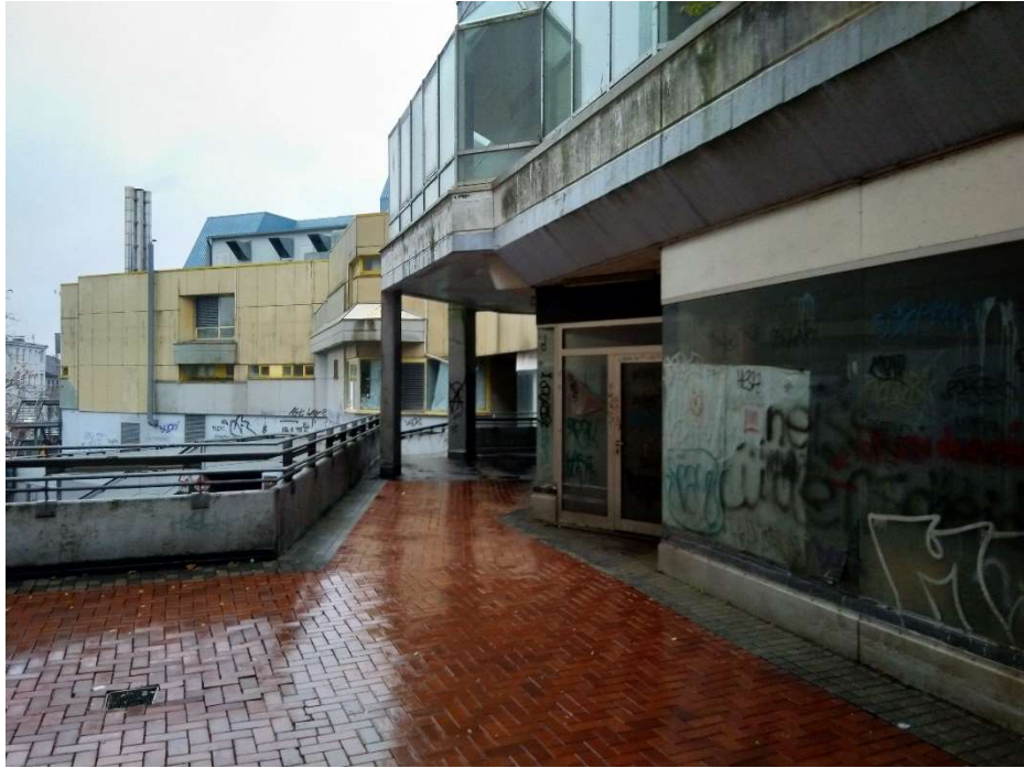
Abb. 8: Fußgängerweg an der Seite des Forums zur Sauerfelder Straße (tagsüber)
