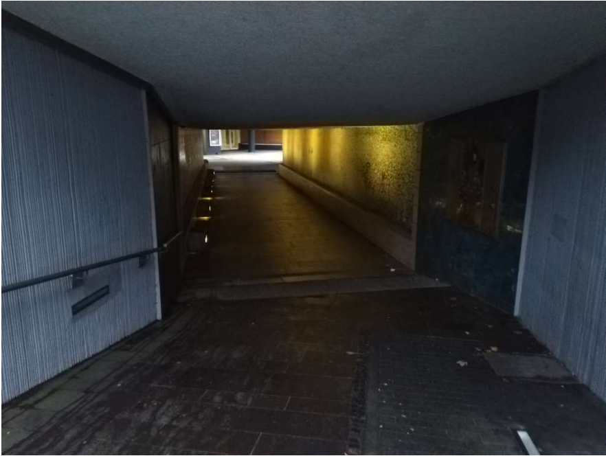
Abb. 11: Eingang Tunnel unter der Sauerfelder Straße (Seite Forum)
