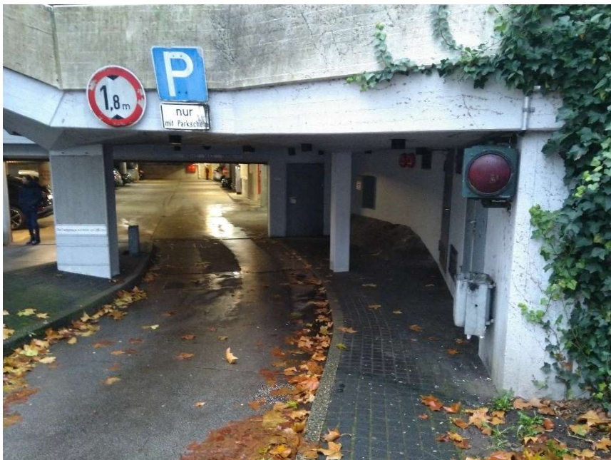
Abb. 15: Eingang Tiefgarage unter dem Kulturhaus Lüdenscheid
