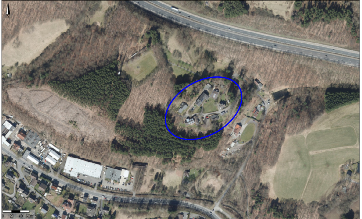
Bild 2: Luftbild aus dem Geodatenportal des Landes NRW (TIM-Online 2.0) [6], 2019, mit Kennzeichnung der Bestandsbebauung des Campus Wislade (blaues Oval)
