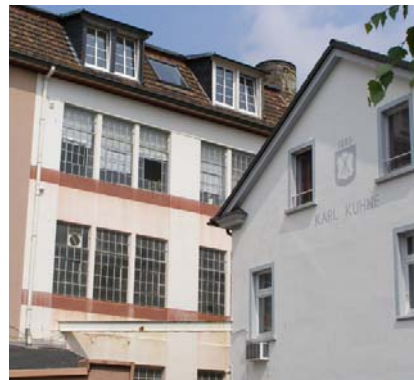
Gründerzeitliche Fabrik Nordstraße
